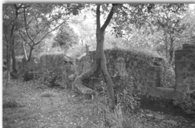
Fuerte de Ametzagaña. Batería de artillería. Son visibles las cañoneras abiertas en el parapeto, así como las banquetas, sobre las que se ha instalado vegetación.
