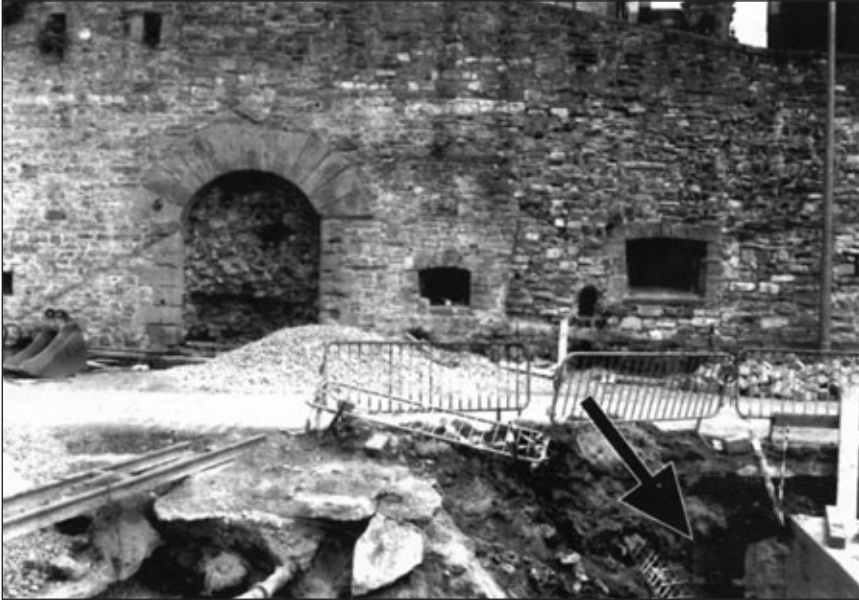
Lámina 1. Vista de las obras de excavación en el puerto en 1990.
